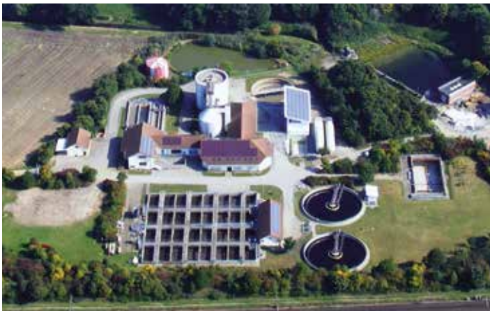
Die Zentralkläranlage in Goddelau
