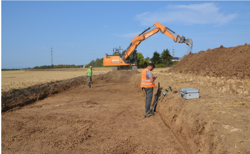
Abb. 2: Arbeitsfoto. Mitarbeiter der PD Bohr und der SPAU beim Oberbodenabtrag in Fläche 4. (Foto: A. Weber)
