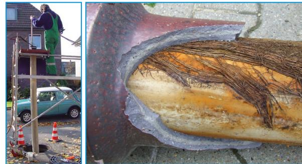
Sanierung von Wurzelschäden: Links wird ein Schlauchliner vom Hauptkanal aus eingezogen. Der Liner ist wurzeldicht. Die Wurzeln konnten sich nur zwischen Liner und Altrohr ausbreiten (rechts).
