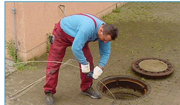
Professionelle Entnahme einer Wurzelprobe und Vermessung der Position
