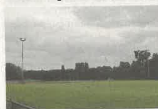
Das Flutlicht auf dem Sportplatz Goddellau wurde auf LED umgestellt.
