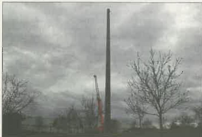
Rund 70 Meter hoch ist der neue Funkmast für Sicherheitsbehörden und -Organisationen.
