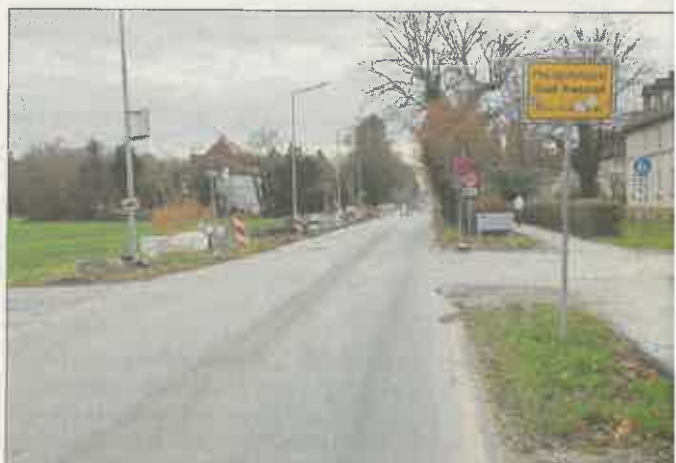
Die Philippsanlage muss für voraussichtlich vier Wochen einseitig gesperrt werden.
