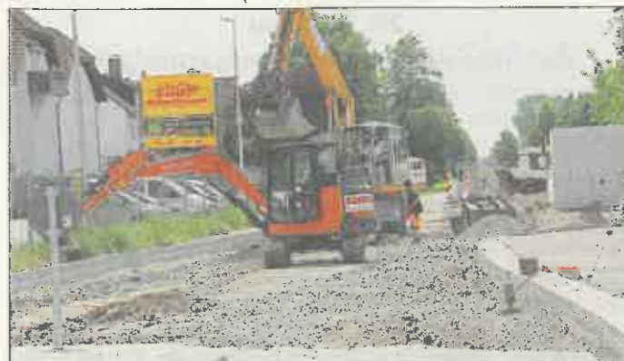
Die Baustelle auf der Starkenburger Straße geht zügig voran.
