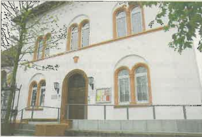
Das denkmalgeschützte ehemalige Rathaus im Stadtteil Crumstadt
