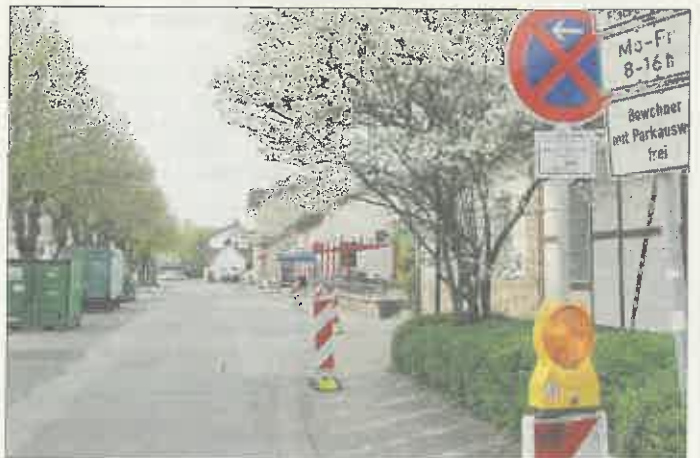
Die Bushaltestelle am Bahnhof Goddelau wird barrierefrei ausgebaut.
