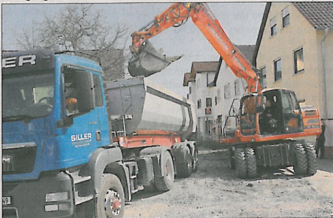
Mit den wärmeren Temperaturen kommt die Baustelle an der Bahnhofstraße wieder auf Touren
