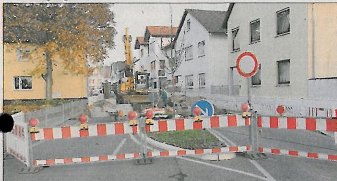
Absperrung in der Bahnhofstraße, Höhe Hausnummer 28
