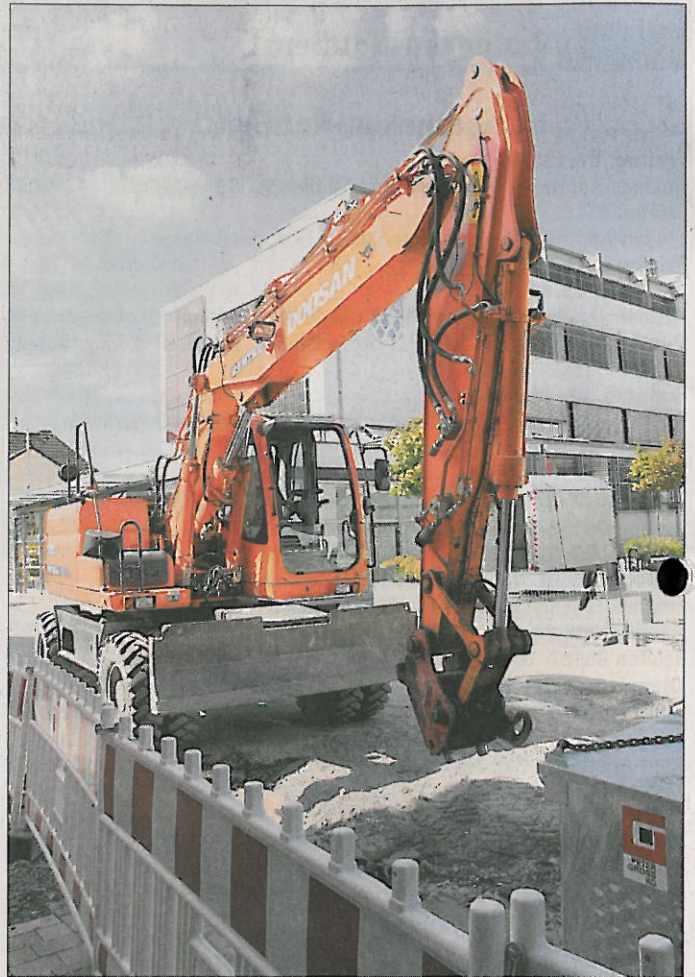
Stillstand an der Baustelle: Telekom verursacht Bauverzögerung
